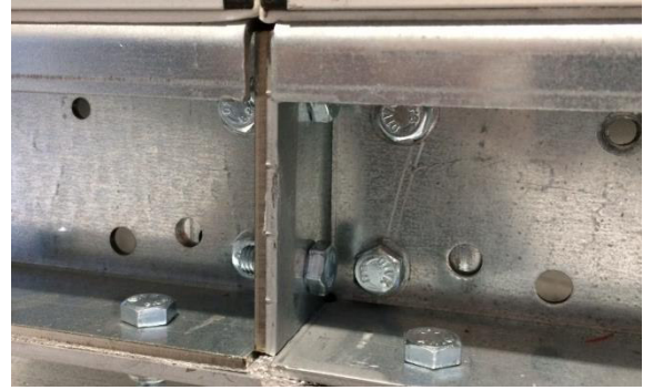
Resim 60: Taban çerçevesinin cıvatalanması
