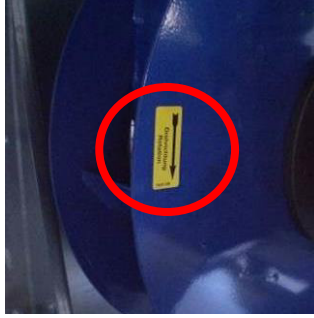
Resim 201: Plug fanların dönüş yönü işareti
