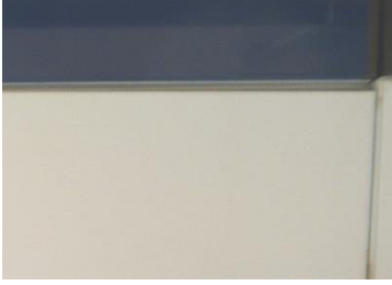
Resim 123: Eğilmiş kapı paneli - aralık açıklığı değişmiş
