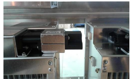
Resim 165: Elektrostatik filtrelerin fişli bağlantısı
