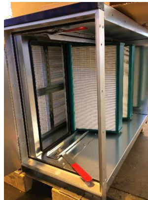
Resim 152: Filtrelerin takılma sırası filtre çerçevesinin ızgarasına uygun olmalıdır
