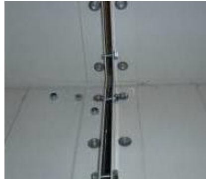
Resim 67: Bağlantı pekiştirme köşebentiyile bağlama
