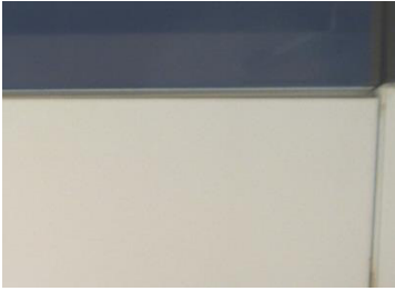
Resim 126: Eğilmiş kapı paneli - aralık açıklığı değişmiş
