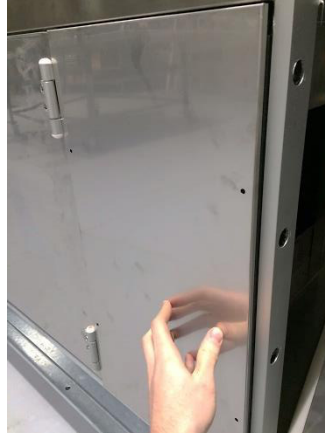
Resim 93: Vidalanmamış dış panel
