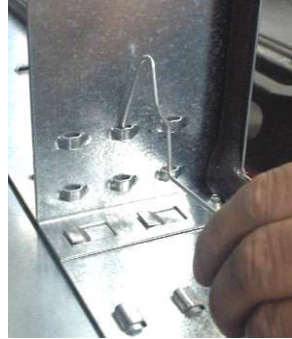
Resim 145: Klipslerin takılması
