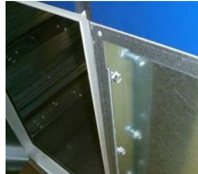
Resim 74: Kapı çerçevesi / iç panel bağlantısı
