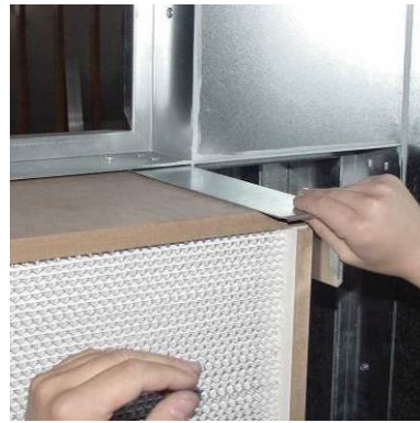
Resim 157: Filtre hücresinin takılması
