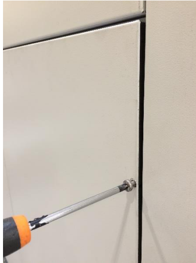
Resim 133: Vidayı çıkararak kapı panelinin (TRA-E) çerçeveden sökülmesi
