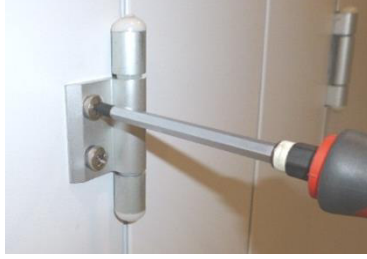
Resim 124: Kapı panelinin konumunun ayarlanması (EU.T)
