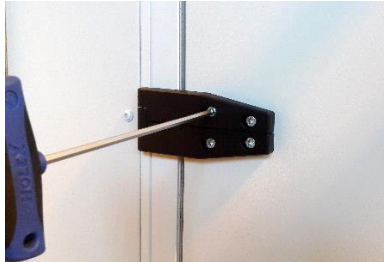
Resim 127: Kapı panelinin konumunun ayarlanması (ZIS)
