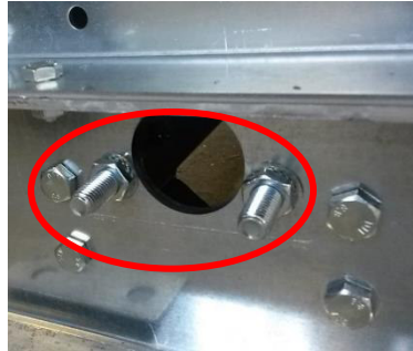
Resim 26: Yekpare mapalar için fabrikada yapılan hazırlık.
