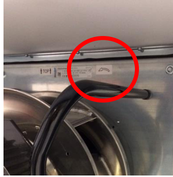
Resim 203: EC fanların dönüş yönü işareti
