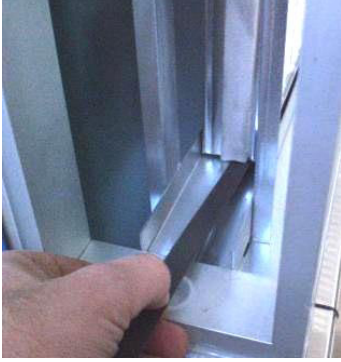
Resim 142: Filtrelerin çekilerek çıkarılması
