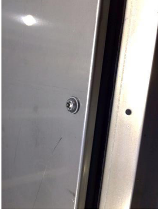
Resim 56: Dış panellerin yerleştirilmesi
