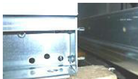
Figur 77: Applicering av självgångande skruvar
