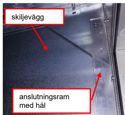
Figur 88: Anslutningsram och skiljevägg (ej skruvade ännu)
