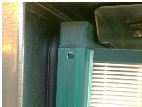
Figur 164: Kontrollera, om filtret ligger an mot tätning
