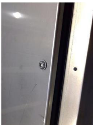
Figur 57: Montering av de externa panelerna
