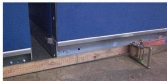
Figur 54: Dra AHU-sektioner tillsammans (detalj)
