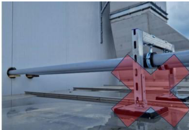
Figur 40: Felaktig rördragning på plats
