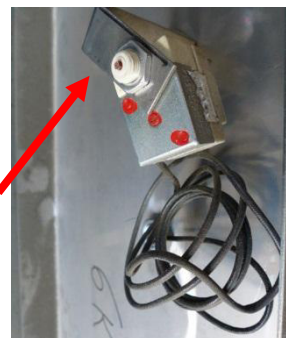
Figur 225: termostat utan täcklock på resetknappen
