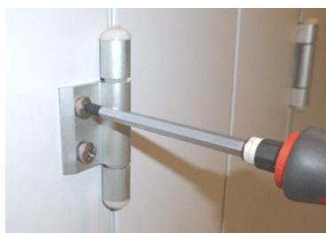
Figur 132: justering av dörrpanelen (EU. T)
