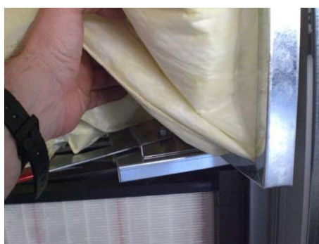
Figur 159: Lyftning av filterpåsar
