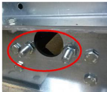
Figur 30: fabriksstillverkad förberedelse för lyftutrustning
