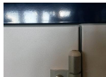
Figur 133: justerad – konstant spaltbredd (EU. T)
