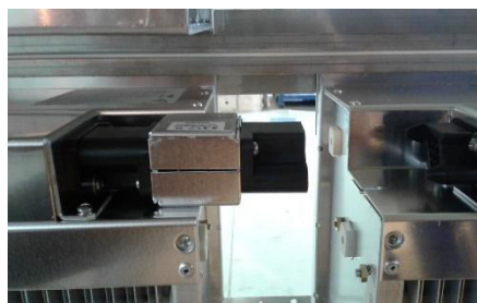
Figur 174: Pluggning av elektrostatiska filter
