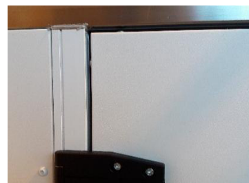
Figur 136: justerad-konstant spaltbredd (ZIS)
