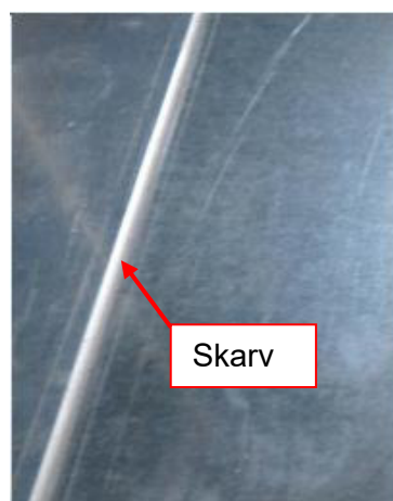
Figur 99: Tätning av sektionanslutning (skarv) med tätningssmedlet
