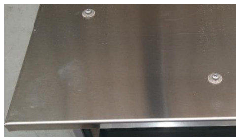
Figur 109: tak av metallplåt monterad
