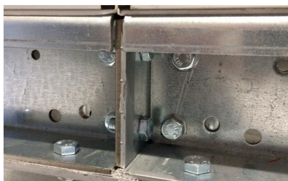
Figur 61: Bultanslutning av basramar
