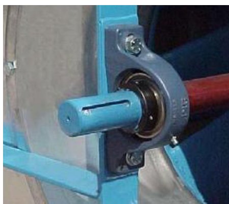
Figur 244: Fläkt lager med smörjniplor (ex. Comefri NTHZ)
