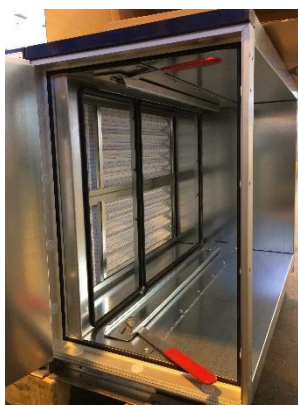
Figur 160: Filterram för olika filterstorlekar
