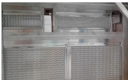
Figur 172: Montering av elektrostatiskt filter
