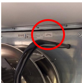
Figur 221: rotations märkning av EC-fläktar
