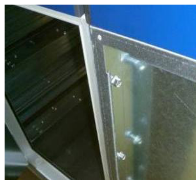
Figur 75: Anslutning mellan dörrkarm/inre panel
