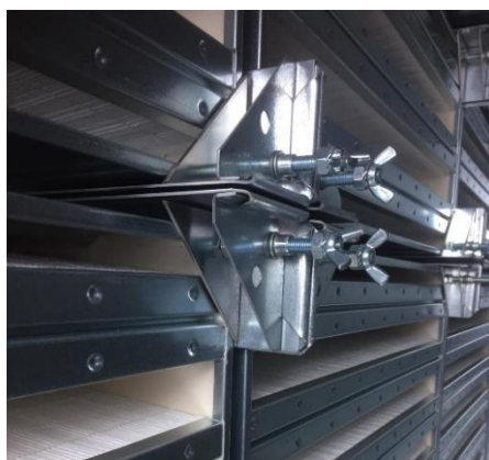
Figur 169: Filterspännare med tryckplatta
