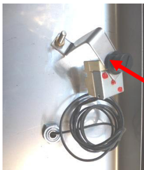
Figur 224: termostat med täcklock på resetknapp
