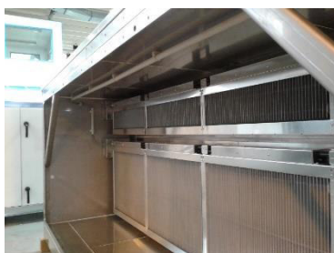
Рисунок 167: Электростатические фильтры в рамке
