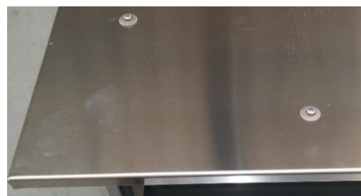
Рисунок 109: Смонтированная крыша из металлического листа
