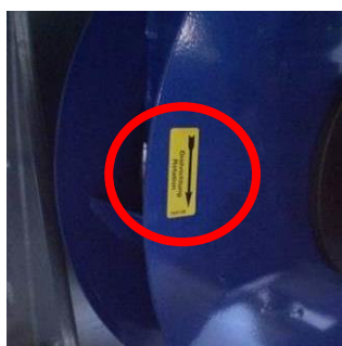
Рисунок 204: Маркировка вращения штепсельных вентиляторов
