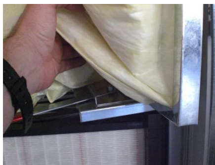
Рисунок 153: Поднятие фильтровальных мешков
