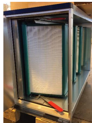
Рисунок 156: секция фильтра со встроенными фильтрами
