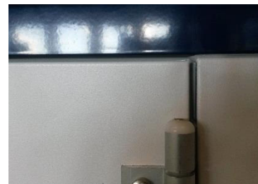
Рисунок 128: отрегулированная-постоянная ширина щели(EU.T)
