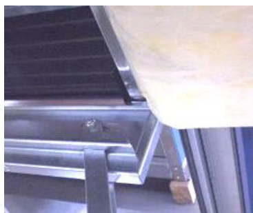
Рисунок 151: Задвиньте фильтры
