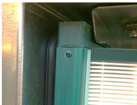
Рисунок 158: проверьте, лежит ли фильтр на уплотнении
