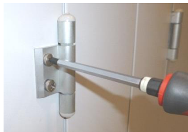
Рисунок 127: регулировка дверной панели (EU.T)
