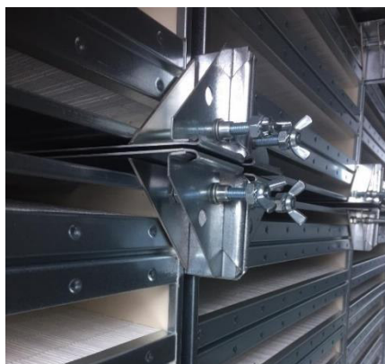
Рисунок 163: Зажим фильтра с прижимной пластиной
