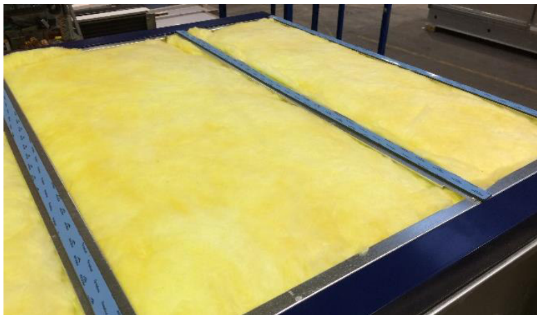
Рисунок 106: Часть СКВ подготовлена к сборке кровли из металлических листов
