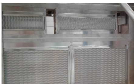
Рисунок 166: Монтаж электростатического фильтра
