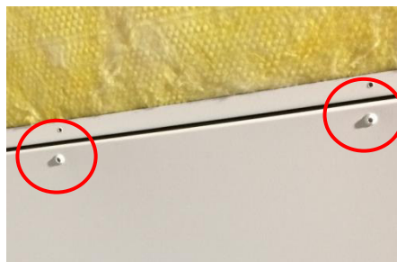
Рисунок 84: Винтовое соединение внутренней и внешней панели
