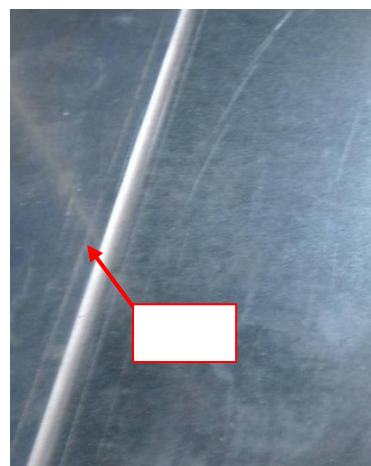
Рисунок 101: Уплотнение соединения секции (стыка) герметиком
