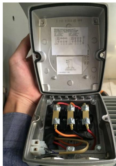
Рисунок 203: Клеммная коробка мотора
