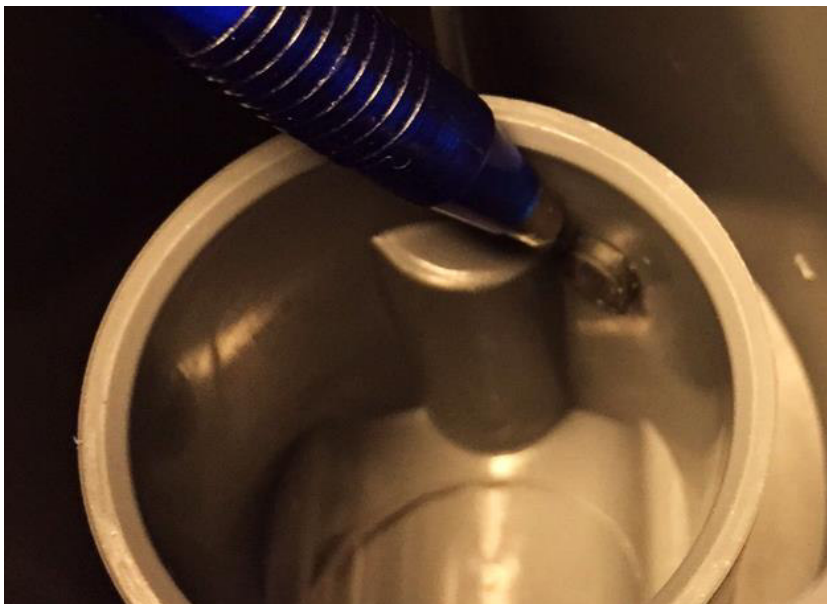
Рисунок 196: Установка со стороны давления: снимите черную заглушку
