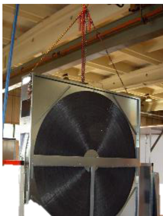
Рисунок 245: Подъем с помощью цепной тали
