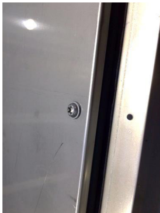
Рисунок 57: Монтаж внешних панелей
