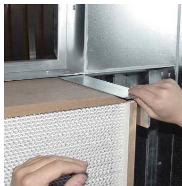
Рисунок 160: Вставка ячейки фильтра
