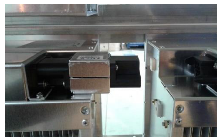
Рисунок 168: Электростатические фильтры со штекерным соединением
