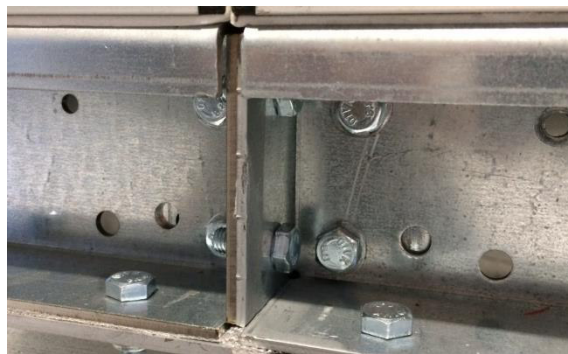
Рисунок 62: Болтовое соединение опорных рам
