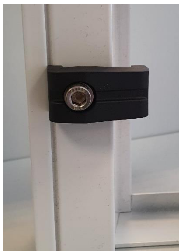
Рисунок 139: фиксирующий механизм на дверной раме (ZIB)
