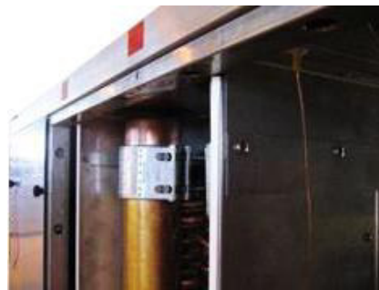
Рисунок 177: смонтированная муфта STRAUB
