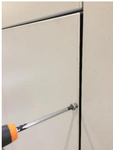
Рисунок 131: снятие дверной панели (TRA-E) от дверной рамы
