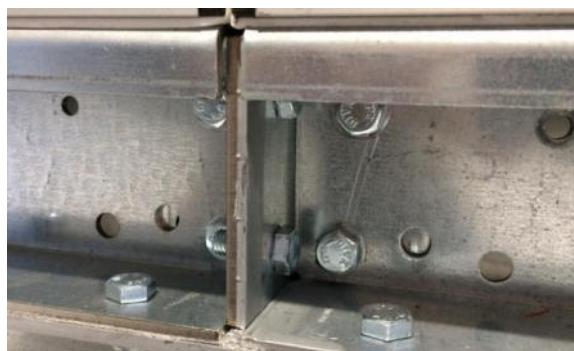
**Рисунок 57:** Болтовое соединение опорных рам
