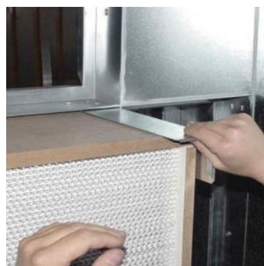
Рисунок 155: Вставка ячейки фильтра
