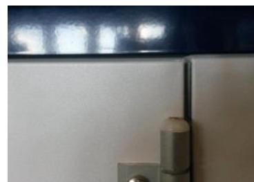
**Рисунок 123:** отрегулированная-постоянная ширина щели(EU.T)
