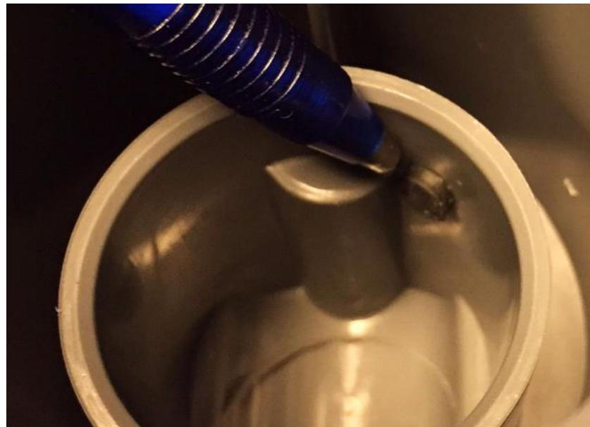
Рисунок 183: Установка со стороны давления: снимите черную заглушку
