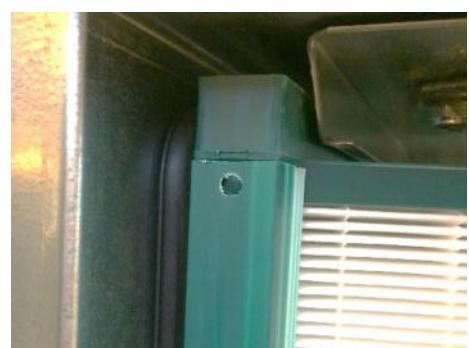
**Рисунок 153:** проверьте, лежит ли фильтр на уплотнении
