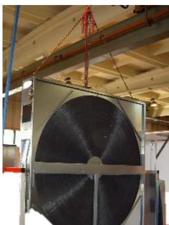
Рисунок 231: Подъем с помощью цепной тали
