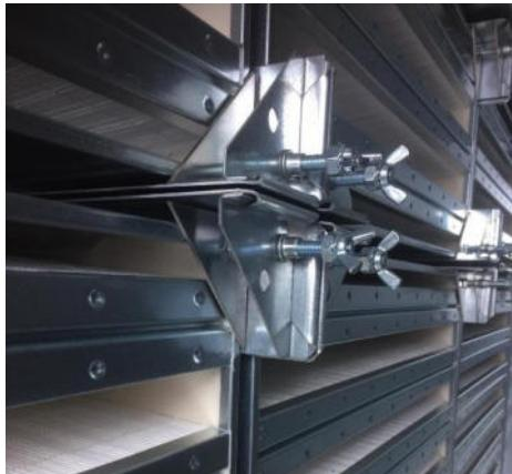
Рисунок 158: Зажим фильтра с прижимной пластиной
