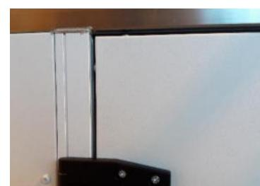
**Рисунок 126:** Отрегулировано постоянная ширина щели(ZIS)
