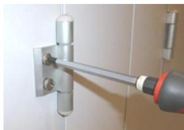
**Рисунок 122:** регулировка дверной панели (EU.T)
