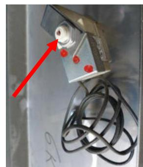
Рисунок 70: Термостат с открытой кнопкой сброса
