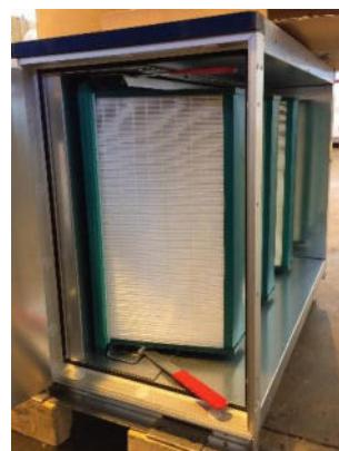
Рисунок 50: секция фильтра со встроенными фильтрами
