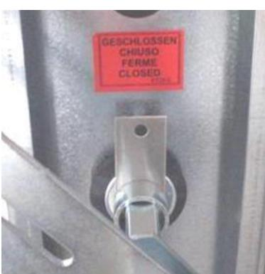
Рисунок 42: на закрытое положение указывает индикатор положения из листового металла
