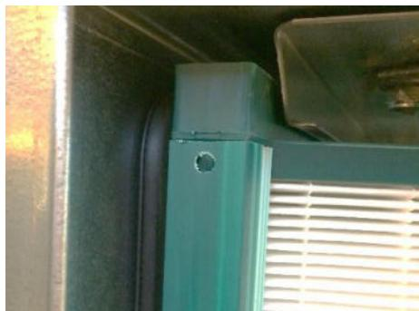
**Рисунок 52:** проверьте, лежит ли фильтр на уплотнении
