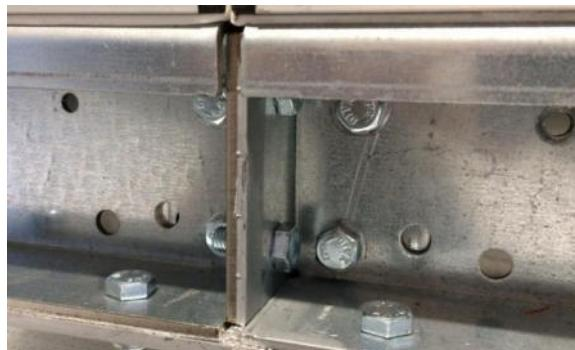
Рисунок 25: Болтовое соединение опорных рам
