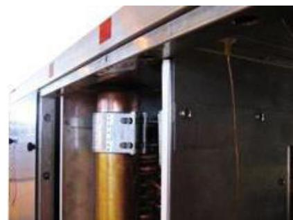
Рисунок 57: смонтированная муфта STRAUB
