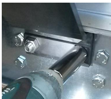
Figur 28: Festing av metallarket og monoblokkkløftefester med mutre
