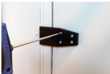
Figur 128: Justering av lukepanelet (ZIS)
