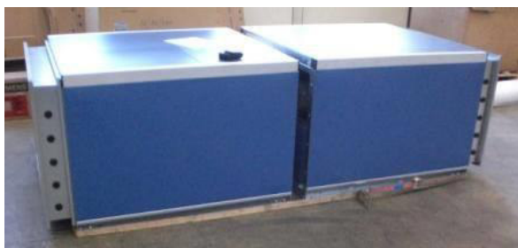
Figur 52: Trekk AHU-seksjonene sammen
