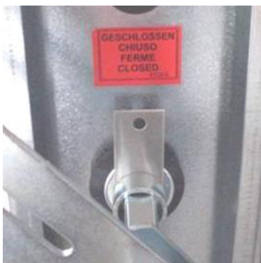
Figur 141: Lukket stilling, preget av en posisjonsindikator for metallplater
