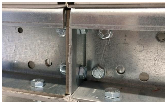
Figur 60: Skrueforbindelse på grunnrammer
