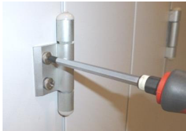
Figur 125: Justering av lukepanelet (EU.T)
