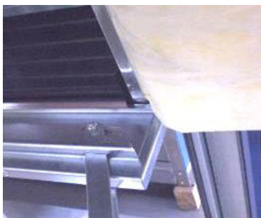
Figur 149: Skyv inn filtrene
