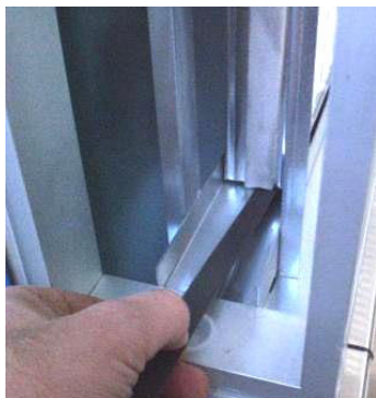
Figur 143: Udrækning af filtrene
