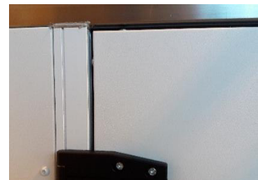
Figur 129: Justert - jevn spaltebredde (ZIS)
