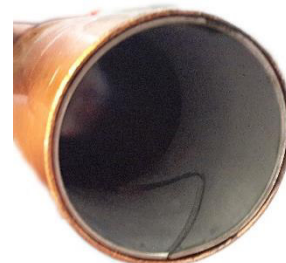
Figur 173: Kobberrør med innsatt forsterkningsring
