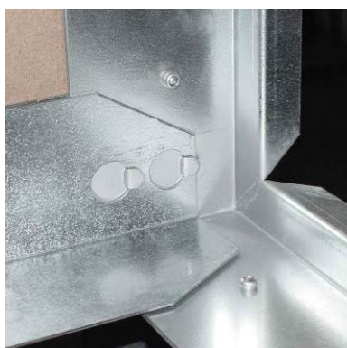
Figur 157: Festing av brakettene
