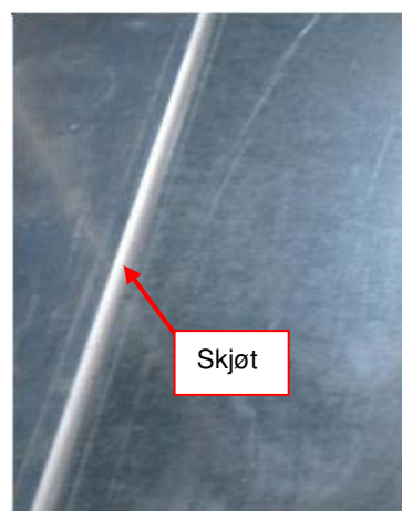
Figur 99: Tetning av seksjonsforbindelse (skjøt) med tetningsmiddel
