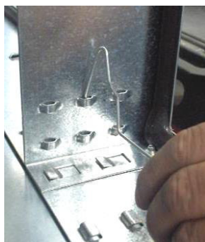
Figur 146: Plassering av klemmene
