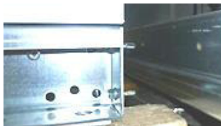
Figur 77: Bruk av selvtappende skruer
