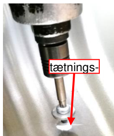
Figur 106: tetningsmiddel tatt i bruk (Sikaflex)
