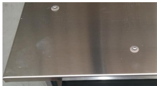
Figur 107: Montert metallplatetak
