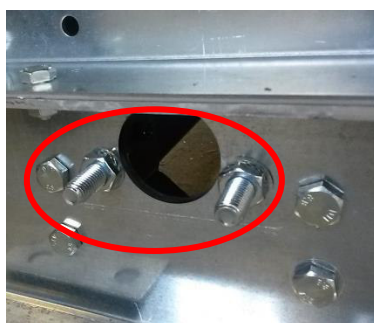
Figur 26: Fabrikkutført klargjøring av løftefester på monoblokk
