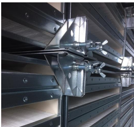
Figur 161: Filterstrammer med trykkplate
