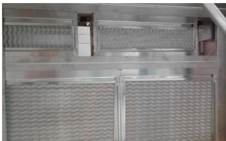
Figur 164: Montering av elektrostatisk filter
