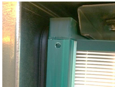
Figur 156: Sjekk om filteret ligger mot tetningen
