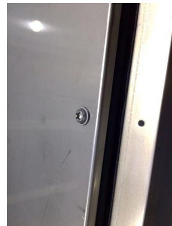
Figur 95: Det ytre panelet er skrudd fast
