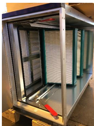
Figur 153: Velg rekkefølge i samsvar med filterrammemønsteret
