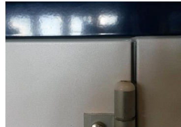
Figur 126: Justert – jevn spaltebredde (EU.T)
