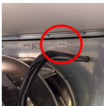
Figur 204: Rotasjonsmarkering av EC-vifter
