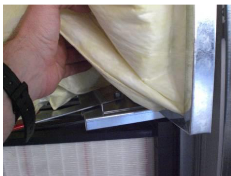
Figur 151: Løft filterposene
