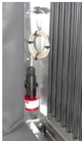
Figur 170: Montert gassdetektor
