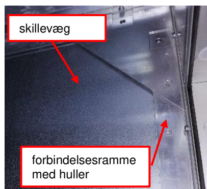
Figur 88: Koblingsramme og skillevegg (ikke skrudd ennå)
