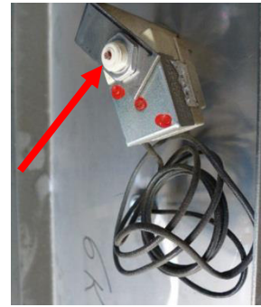
Figur 208: Termostat med tilbakestillingsknapp uten deksel
