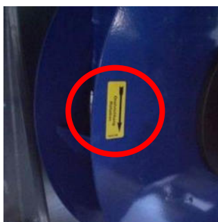
Afbeelding 190: Markering draairichting plugventilator
