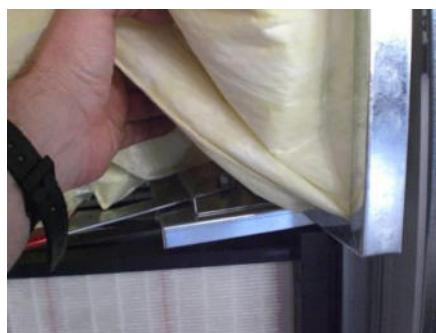
Afbeelding 147: Filterzakken optillen
