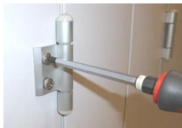
Afbeelding 121: Aanpassen van het deurpaneel (EU.T)
