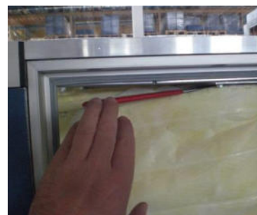
Afbeelding 146: Filters vastklemmen
