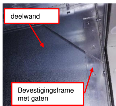
Afbeelding 84: Bevestigingsframe en deelwand (nog niet geschroefd)
