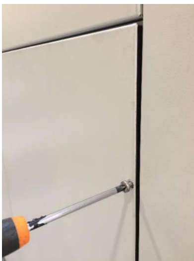
Afbeelding 130: Deurpaneel (TRA-E) losmaken van deurframe
