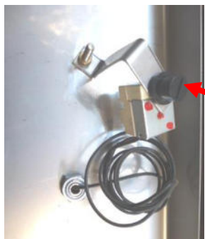
Afbeelding 194: Thermostaat met afsluitdop op resetknop
