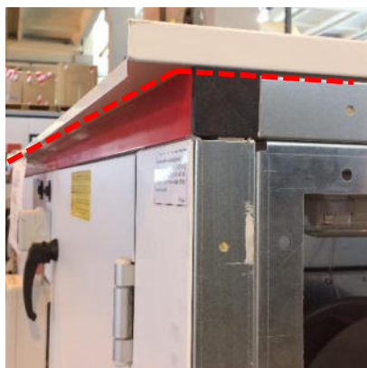
Afbeelding 104: Voegen afdichten met afdichtingsmiddel
