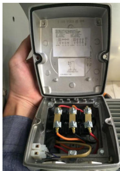
Afbeelding 189: Klemmenkast motor
