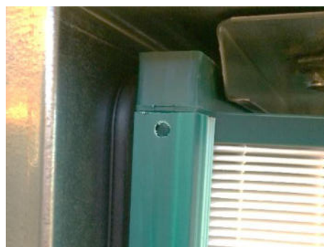
Afbeelding 152: Controleren of het filter op de afdichting ligt
