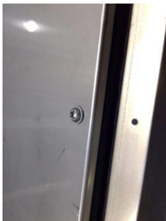
Afbeelding 53: Schroefverbinding van de buitenpanelen
