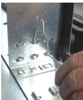
Afbeelding 142: Plaatsing van de klemmen
