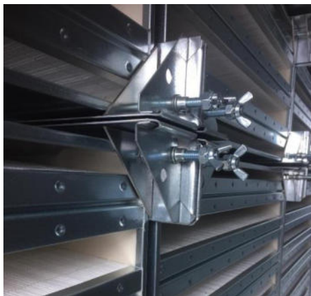
Afbeelding 157: Filterspanner met drukplaat
