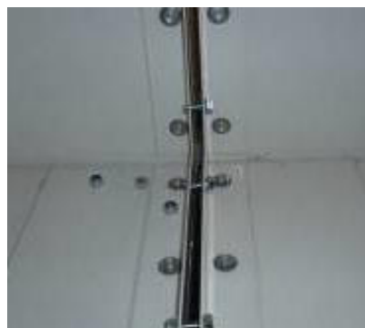
Afbeelding 64: Aansluiting via aansluithoeken
