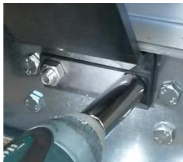
Afbeelding 26: Plaatijzer en hijspunt op monoblok vastzetten met moeren
