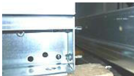
Afbeelding 73: Toepassing van zelftappende schroeven
