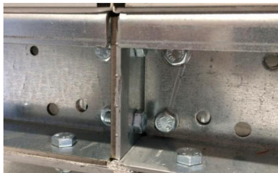
Afbeelding 57: Schroefaansluiting van onderframe
