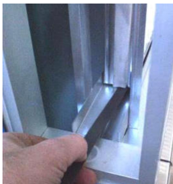
Afbeelding 139: De filters uittrekken
