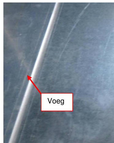
Afbeelding 95: Naad tussen apparaten (voeg) afdichten met afdichtingsmiddel
