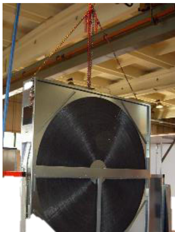
Afbeelding 230: Hijsen met kettingtakel
