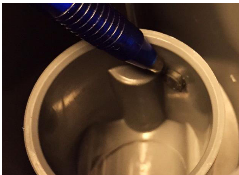
Afbeelding 182: Installatie aan drukzijde: zwarte afsluitplug verwijderen
