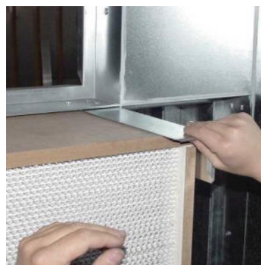
Afbeelding 154: Plaatsen van het filter.
