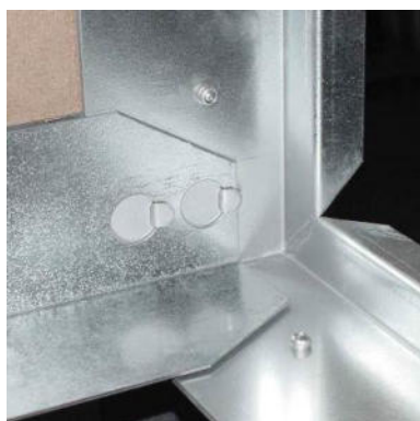
Afbeelding 153: Bevestiging van de beugels
