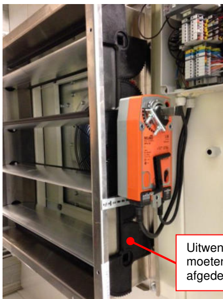
Afbeelding 160: Klep met uitwendige tandwielen
