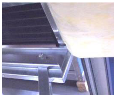
Afbeelding 145: Filters inschuiven
