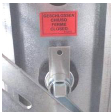
Afbeelding 48: Gesloten positie, gekenmerkt door een plaatmetalen positie-indicator
