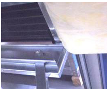
Afbeelding 51: Filters inschuiven
