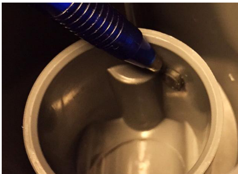
Afbeelding 77: Installatie aan drukzijde: zwarte afsluitplug verwijderen
