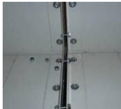
Afbeelding 36: Aansluiting via aansluithoeken
