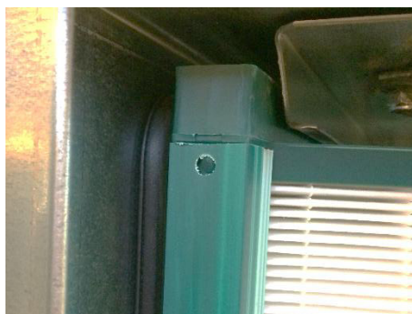
Afbeelding 58: Controleren of het filter op de afdichting ligt
