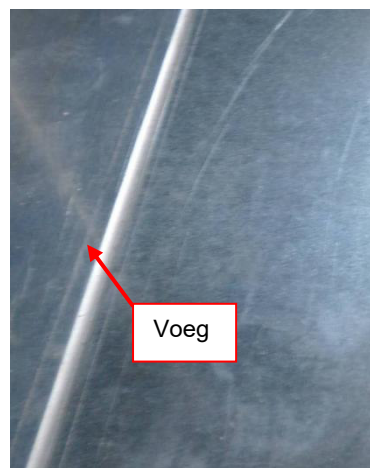
Afbeelding 42: Naad tussen apparaten (voeg) afdichten met afdichtingsmiddel
