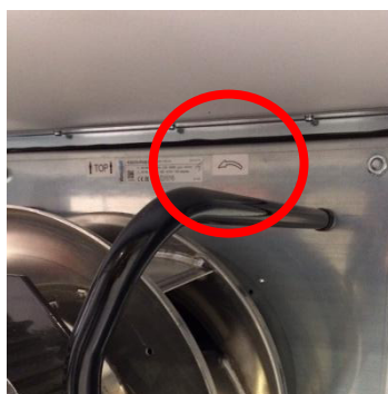
Afbeelding 79: Markering draairichting EC-ventilator
