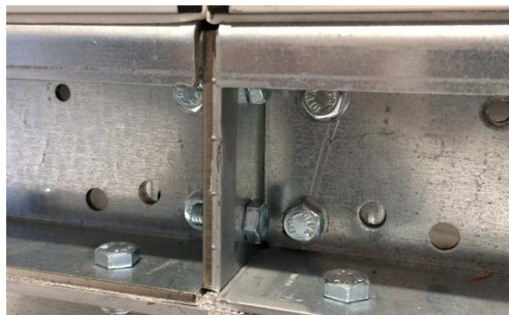
Afbeelding 31: Schroefaansluiting van onderframe
