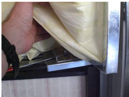
Afbeelding 53: Filterzakken optillen
