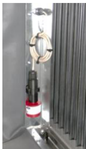
Afbeelding 61: Gemonteerde gasdetector
