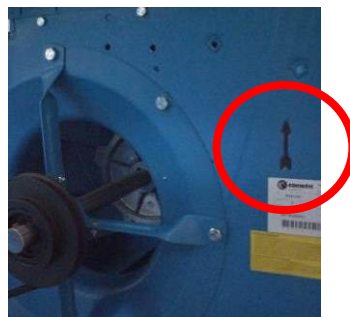
Slika 221: Označevanje vrtenja ventilatorjev ohišij
