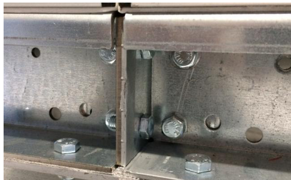
Slika 62: Vijačna povezava osnovnih okvirjev
