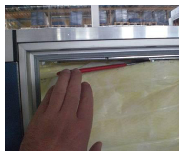
Slika 159: Vpenjanje filtrov
