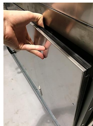
Slika 60: Odstranitev zunanjih panelov
