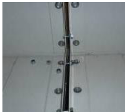
Slika 69: Povezava prek kota utrjevanja povezave
