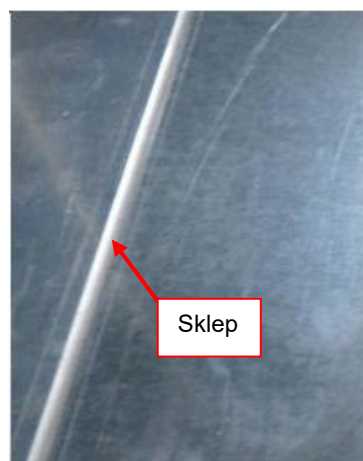
Slika 100: Tesnjenje sekcijske povezave (spoja) s tesnilnim sredstvom
