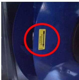
Slika 220: Označevanje vrtenja vtičnih ventilatorjev
