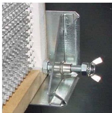
Slika 169: Vpenjanje filtrirne celice
