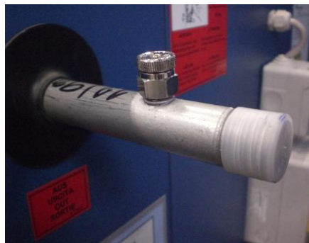
Slika 198: Prezračevalni ventil
