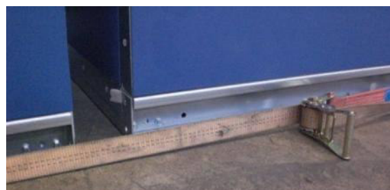
Slika 55: Vlečenje odsekov AHU skupaj (detajl)
