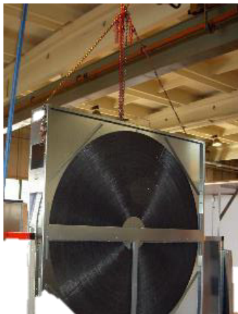
Slika 261: Dviganje z verižnim dvigalom
