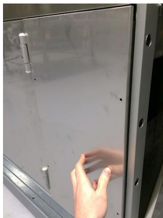
Slika 95: Zunanja plošča ni privita
