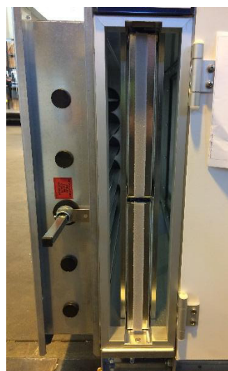
Slika 141: Odstranjena plošča vrat (TRA)
