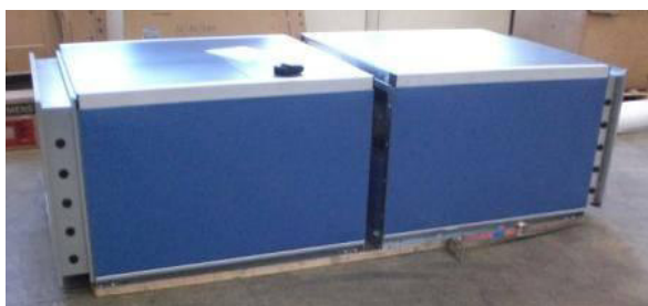
Slika 54: Vlečenje odsekov AHU skupaj
