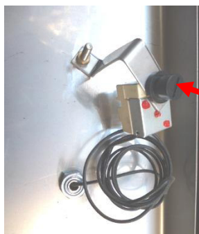
Slika 225: Termostat s pokrovčkom na gumbu za ponastavitev
