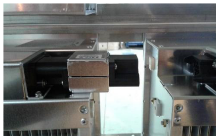
Slika 175: Vtič za priključitev elektrostaticnih filtrov
