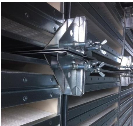
Slika 170: Napenjalec filtra s tlačno ploščo
