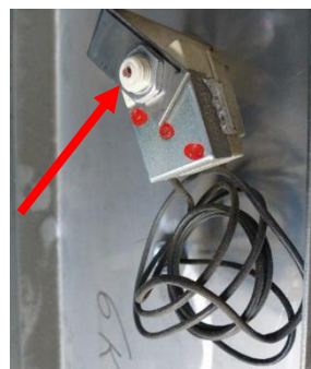
Slika 226: Termostat z nepokritim gumbom za ponastavitev
