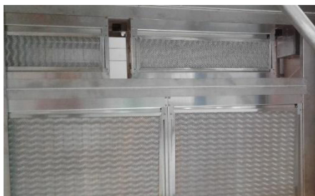
Slika 173: Montaža elektrostaticnega filtra
