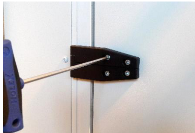
Slika 136: Nastavitev vratne plošče (ZIS)
