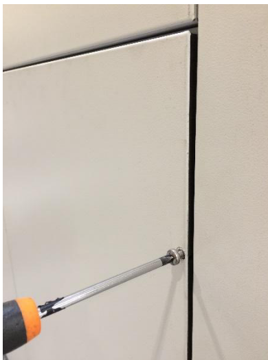
Slika 143: Odvijte vijak in odstranite vratno ploščo (TRA-E) iz okvirja vrat
