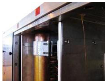
Slika 193: Montirana sklopka STRAUB
