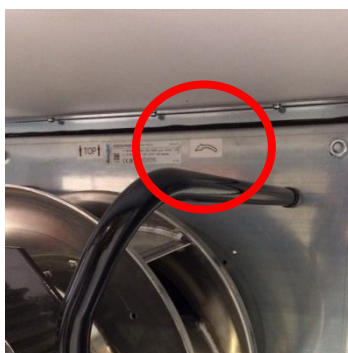
Slika 222: Rotacijska oznaka EC ventilatorjev
