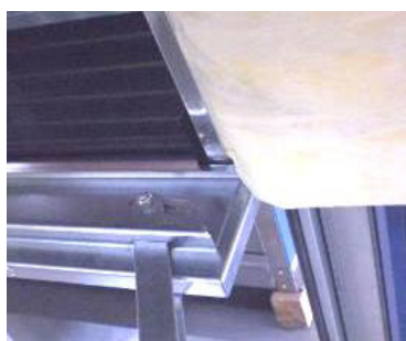
Slika 158: Potisnite filtre
