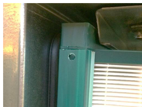
Slika 165: Preverite, ali filter leži na tesnilu
