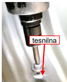
Slika 109: Uporabljena tesnilna masa (Sikaflex)
