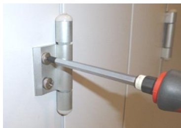
Slika 133: Nastavitev vratne plošče (EU.T)
