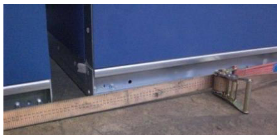
55. ábra: Légkezelő egység szekciók összekapcsolása (részlet)
