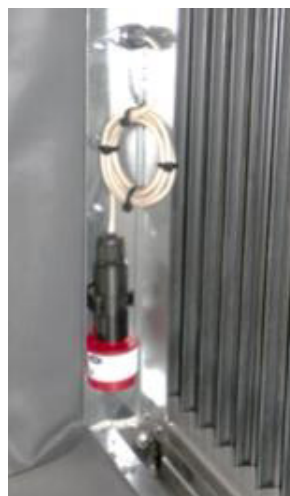
179. ábra: Felszerelt gázérzékelő
