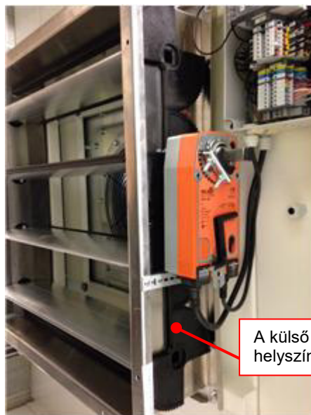
176. ábra: Külső fogaskerekes csappantyú
