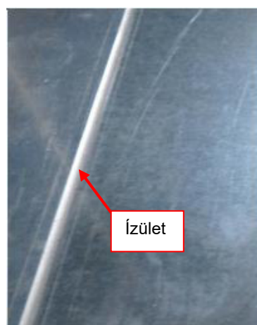
100. ábra: A szakasz csatlakozásának (csatlakozás) tömítése tömítőanyaggal
