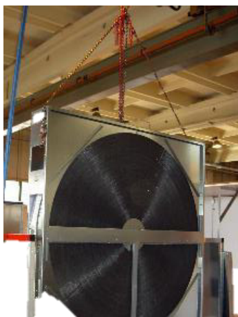
261. Ábra: Emelés láncos emelővel
