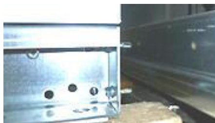
78. ábra: Önmenetes csavarok alkalmazása
