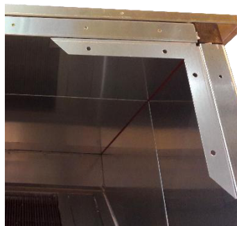
68. ábra: Csatlakozási szög
