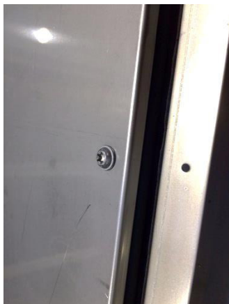
58. ábra: A külső panelek felszerelése
