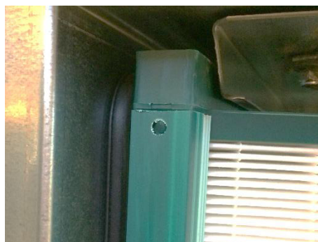
165. ábra: Ellenőrizze, hogy a szűrő a tömítésen fekszik-e
