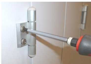
133. ábra: Az ajtópanel beállítása (EU.T)
