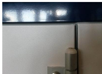
134. ábra: Beállítva – állandó rés szélesség (EU.T)
