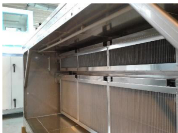
174. ábra: Elektrosztatikus szűrők a szűrőkeretben
