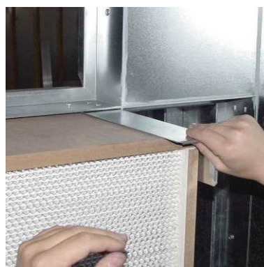
167. ábra: A szűrőcella behelyezése
