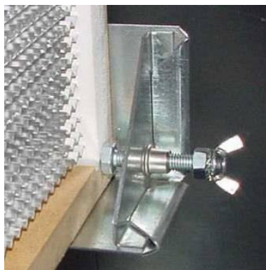
169. ábra: A szűrőcella rögzítése
