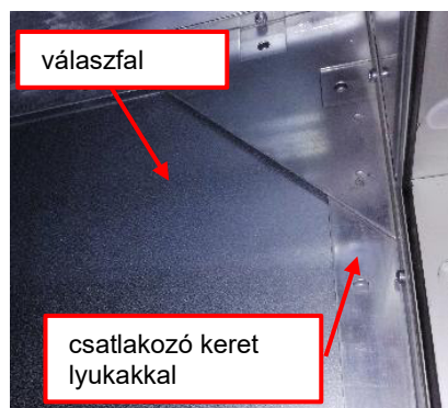
89. ábra: Csatlakozó keret és válaszfal (még nincs becsavarozva)
