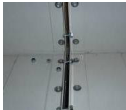
69. ábra: Csatlakozás megerősítő szög segítségével
