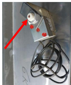
226. ábra: Termosztát fedetlen visszaállító gombbal
