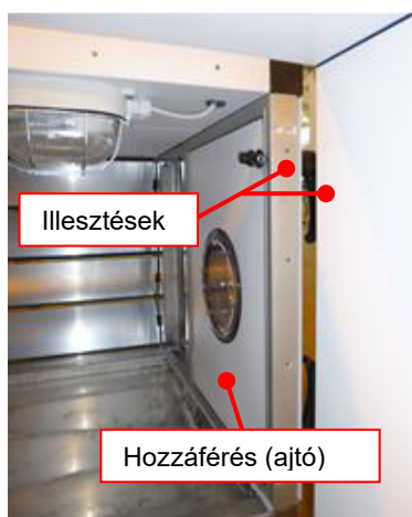
99. ábra: Légkezelő egység elválasztása ajtón keresztül elérhető
