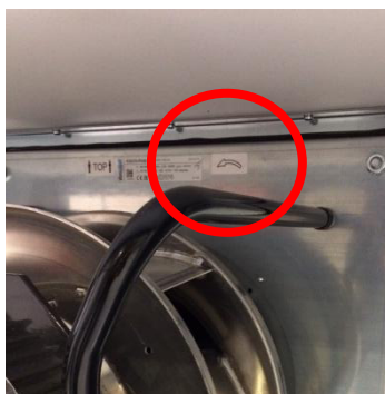
222. ábra: EC ventilátorok forgásjelölése
