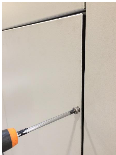
143. ábra: A csavar kicsavarása és az ajtópanel (TRA-E) eltávolítása az ajtókeretből
