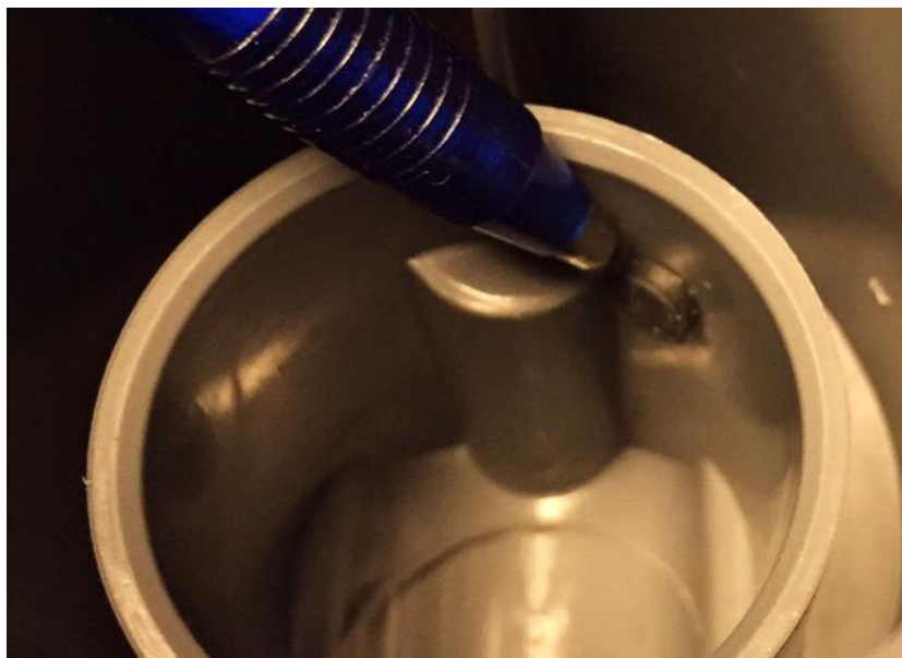
212. ábra: Nyomóoldali telepítés: távolítsa el a fekete záró dugót
