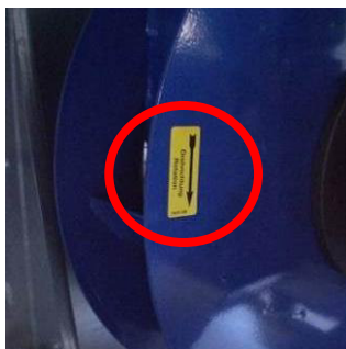
220. ábra: Dugaszolható ventilátorok forgásjelölése
