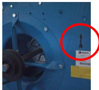
221. ábra: Házas ventilátorok forgásjelölése
