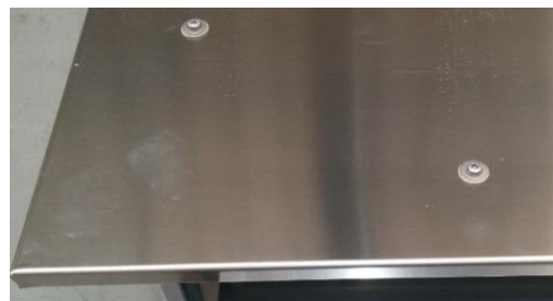
110. ábra: Fémlemez tető felszerelve
