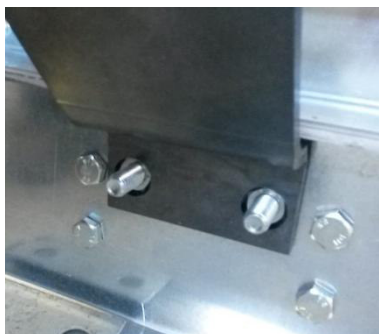
31. ábra: A monoblokkos daru emelőfűl pozicionálása az ellenkeretnél
