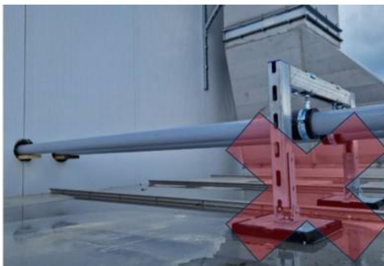
40. ábra: Helytelen helyszíni csővezetés
