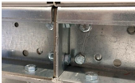
62. ábra: Alapkeretek csavaros csatlakozása
