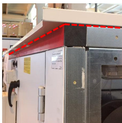
111. ábra: Az illesztések lezárása tömítőanyaggal
