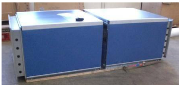
54. ábra: Légkezelő egység szekciók összehúzása
