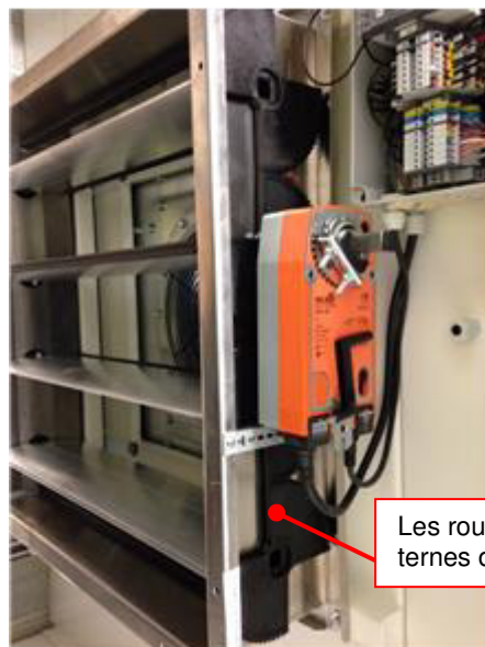
Illustration 164 : Registre avec roues d'engrenage externes
