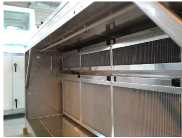
Illustration 162 : Filtres électrostatiques dans le cadre du filtre
