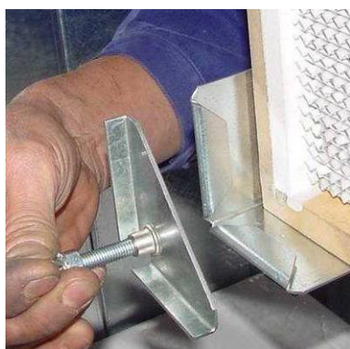
Illustration 156 : Insertion des pinces
