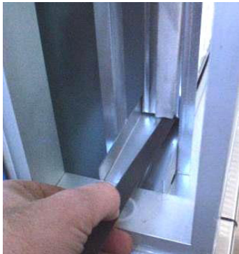
Illustration 140 : Retirer les filtres
