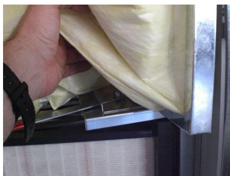
Illustration 148 : Soulever les sacs filtrants
