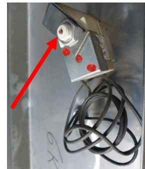
Illustration 203 : Thermostat avec bouton de réinitialisation non couvert
