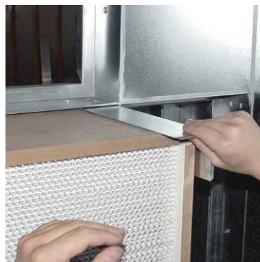
Illustration 155 : Insertion de la cellule de filtre
