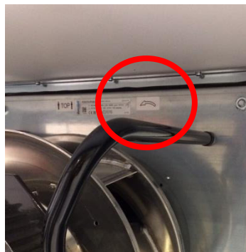
Illustration 199 : Marquage de rotation des ventilateurs EC
