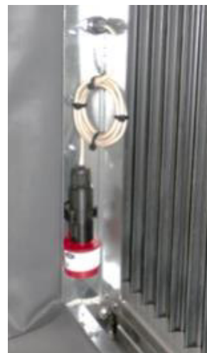
Illustration 167 : Détecteur de gaz monté
