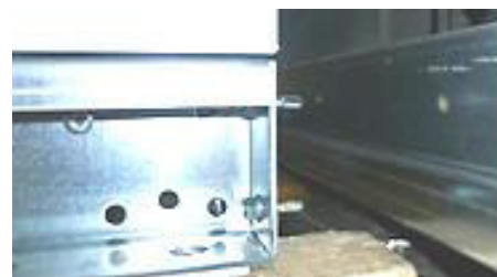
Illustration 74 : Application de vis autotaraudeuses
