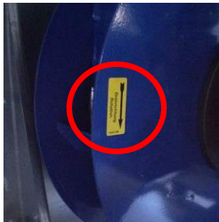
Illustration 197 : Marquage de rotation des ventilateurs enfichables
