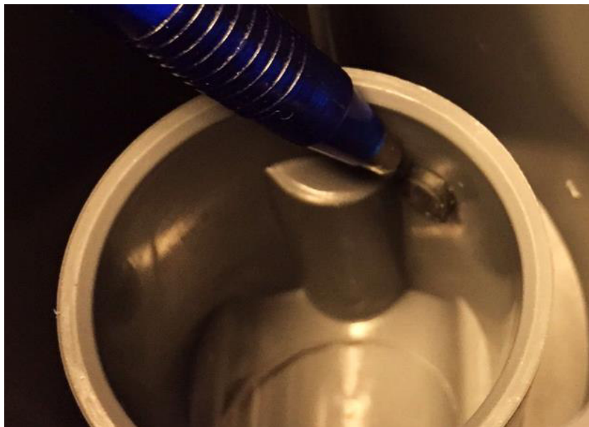
Illustration 189 : Installation du côté pression : retirez la fiche d'embout noir
