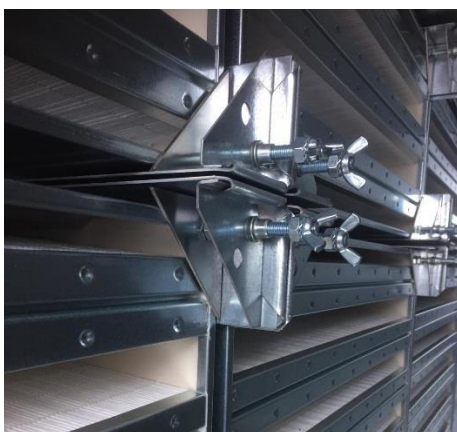
Illustration 158 : Tendeur de filtre avec plaque de pression
