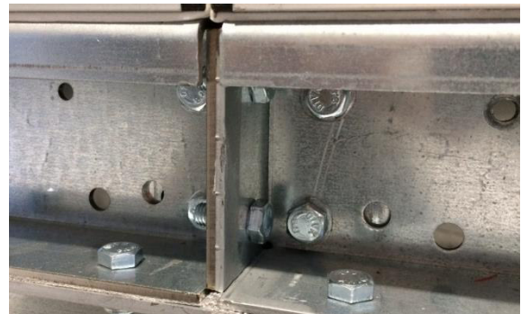
Illustration 57 : Assemblage par boulon des châssis de base
