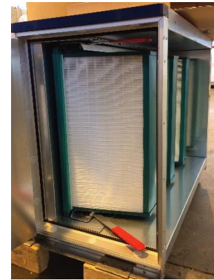
Illustration 151 : section de filtre avec filtres insérés
