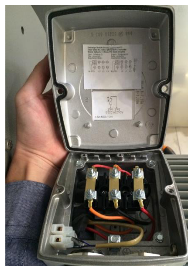
Illustration 196 : Bornier du moteur
