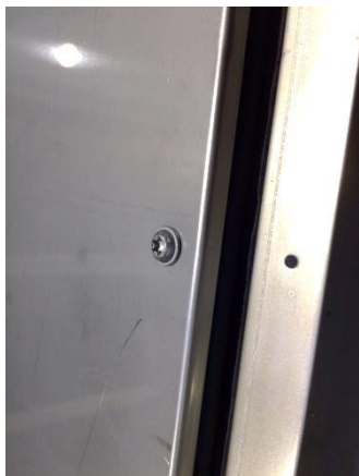
Illustration 52 : Montage des panneaux externes
