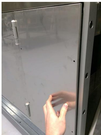
Illustration 53 : Panneau externe avec vis dévissées
