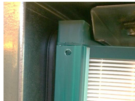
Illustration 153 : vérifiez si le filtre repose contre le joint d'étanchéité
