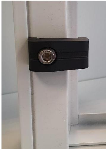
**Illustration 39** : mécanisme de fixation au niveau du châssis de porte (ZIB)
