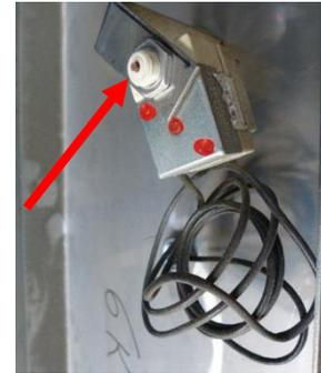
**Illustration 74** : Thermostat sans bouchon sur le bouton de réarmement
