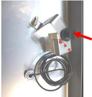
**Illustration 73** : Thermostat avec un bouchon sur le bouton de réarmement
