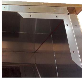
**Illustration 28** : Angle de raccordement
