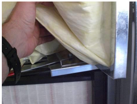
Kuva 153: Suodatinpussien nostaminen
