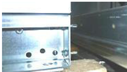
Kuva 79: Itseporautuvien ruuvien kiinnitys
