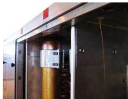
Kuva 177: Asennettu STRAUB-kytkentä
