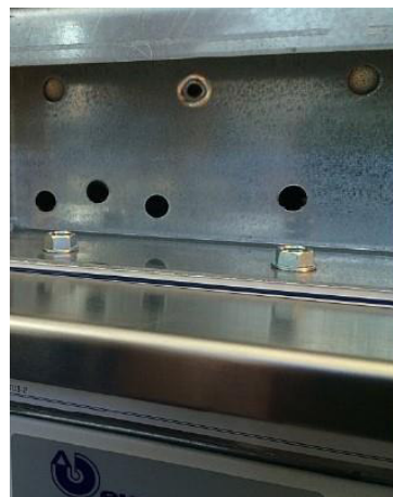
Kuva 88: Kahden päällekkäisen laitteen kytkentä
