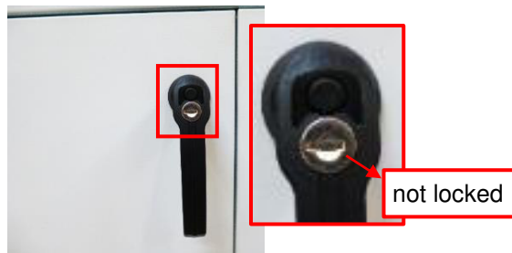
Kuva 118: Ovi 'kiinni', ei lukittu
