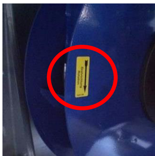
Kuva 204: Pistopuhaltimien kiertomerkinnot
