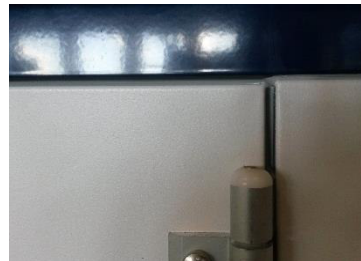
Kuva 128: Säädetty - vakio raon leveys (EU.T)
