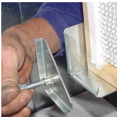
Kuva 161: Kiinnittimien asettaminen paikalleen
