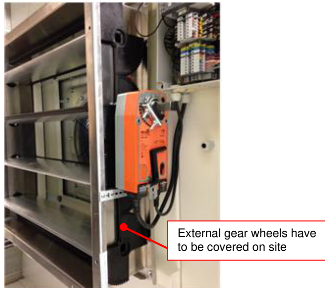
Kuva 169: Sulkupelti ulkoisilla hammaspyörillä
