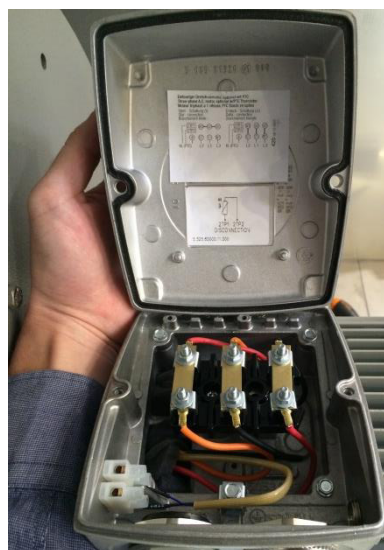
Kuva 203: Moottorin liitäntäkotelo
