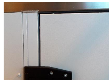
Kuva 131: Säädetty - vakio raon leveys (ZIS)
