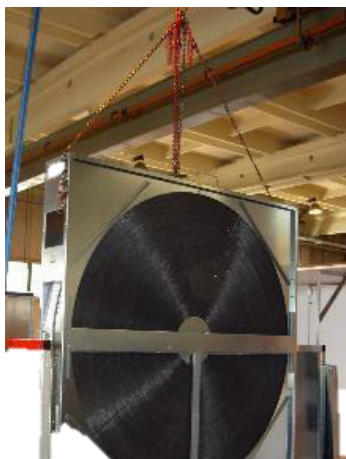
Kuva 245: Nostaminen ketjunostimella
