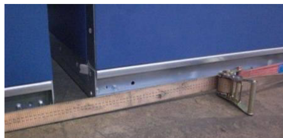
Kuva 55: Ilmanvaihtokoneen osien vetäminen yhteen (yksityiskohta)
