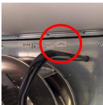
Kuva 206: EC-puhaltimien pyörimismerkintä
