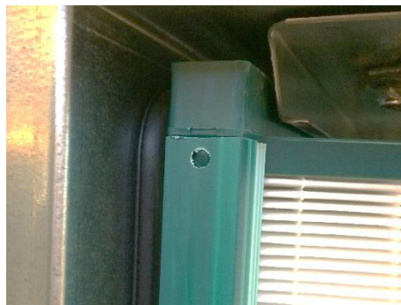
Kuva 158: Tarkista, onko suodatin tiivisteeseen päällä
