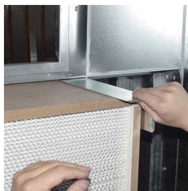
Kuva 160: Suodatinkennon asettaminen paikalleen
