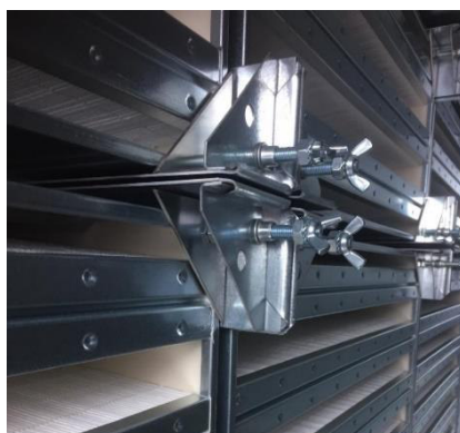
Kuva 163: Suodatinkiristin painelevyllä
