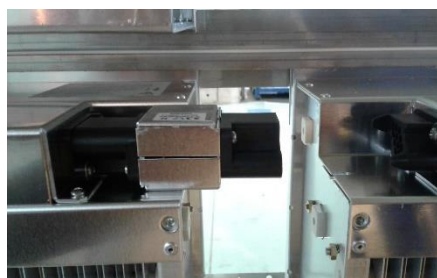
Kuva 168: Sähköstaattisten suodattimien pistokeliitäntä
