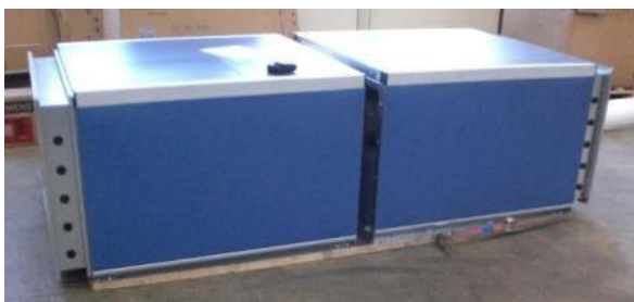
Kuva 54: Ilmanvaihtokoneen osien vetäminen yhteen
