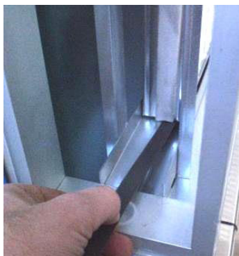
Kuva 145: Suodattimien vetäminen ulos
