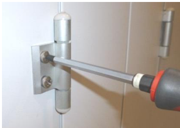
Kuva 127: Ovilevyn säätö (EU.T)
