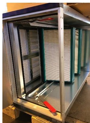
Kuva 155: Tarkastele suodatinkehysen kehysen mukaista järjestystä
