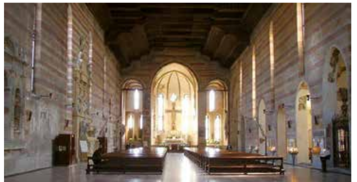
Kirche der Eremiten, Padova (2011) - 40 Gebläsekonvektoren
