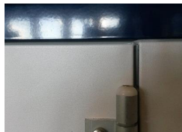
Fig. 125: Justeret – konstant spaltebredde (EU.T)
