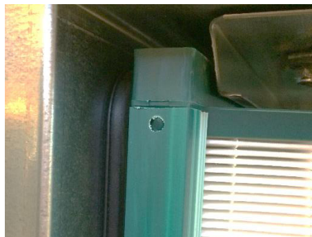
Fig. 155 : Kontrollér, om filteret ligger på tætningen
