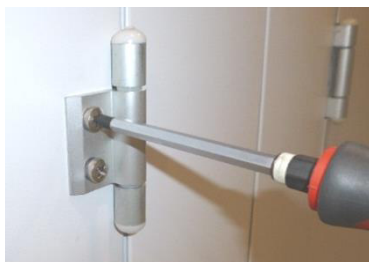
Fig. 124: Justering af dørpanelet (EU.T)
