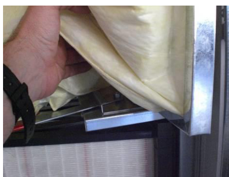
Fig. 150: Løft af filterposerne
