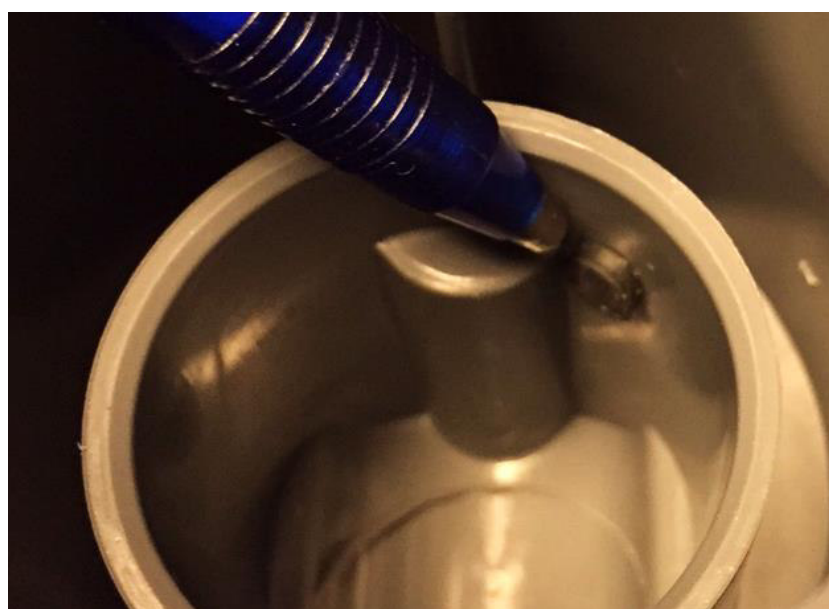
Fig. 193: Installation på tryksiden: fjern den sorte lukkeprop
