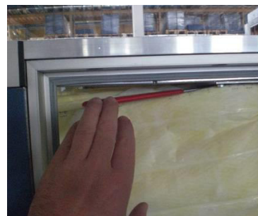
Fig. 149: Fastspænding af filtrene
