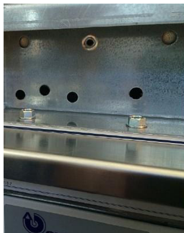
Fig. 85: Forbindelse af to enheder oven på hinanden
