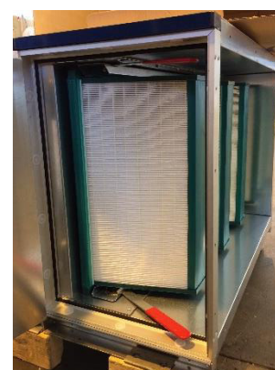
Fig. 153: Filtersektion med indsatte filtre
