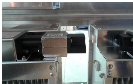
Fig. 165: Stik tilslutning elektrostatiske filtre
