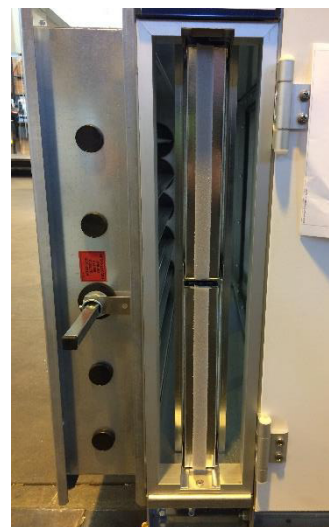
Fig. 131: demonteret dørpanel (TRA)
