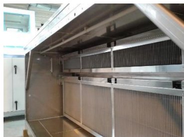
Fig. 164: Elektrostatisk filter i filterrammen
