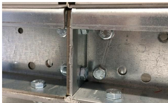
Fig. 60: Skruetilslutning af bundrammen
