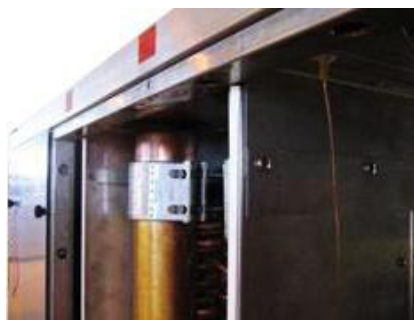
Fig. 174: Monteret STRAUB-kobling
