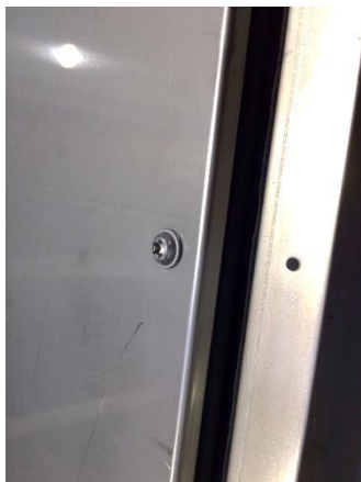
Fig. 56: Montering af udvendige paneler
