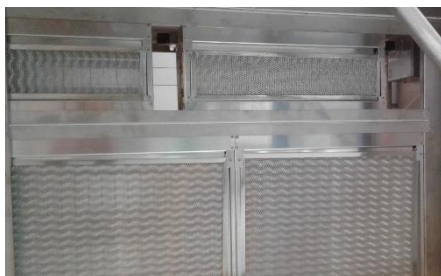
Fig. 163: Montering af elektrostatiske filtre
