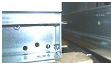
Fig. 76: Montering af selvskærende skruer
