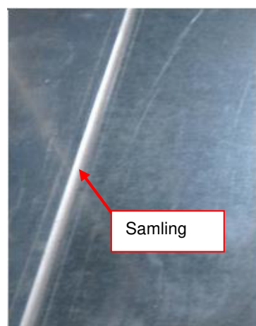
Fig. 98: Forsegling af sektionforbindelsen (samling) med tætningsmidlet
