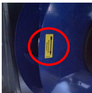
Fig. 201: Rotationsmærkning på indstiksventilatorer
