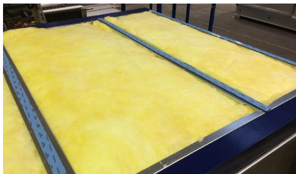
Fig. 103: En del af enheden er forberedt til montering af metalpladetag
