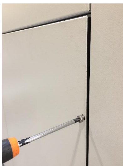
Fig. 133: Afmontering af dørpanelet (TRA-E) fra dørkarmen
