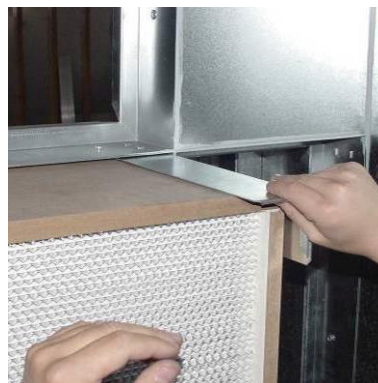
Fig. 157: Indsættelse af filtercellen
