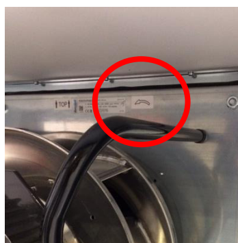
Fig. 203: Rotationsmærkning af EC-ventilatorer
