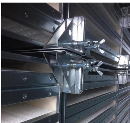
Fig. 160: Filterstrammer med trykplade
