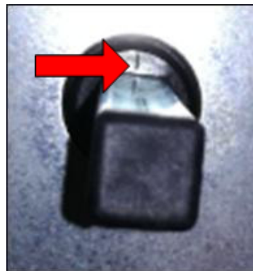
Abbildung 50: Schließstellung, gekennzeichnet durch eine Markierung am Zahnrad
