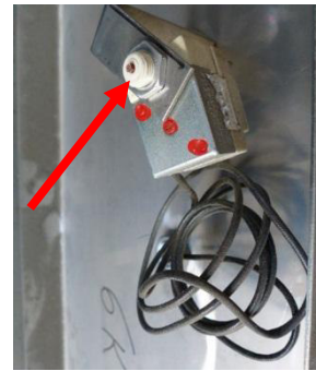
Abbildung 83: Thermostat mit freigelegtem Rückstellknopf
