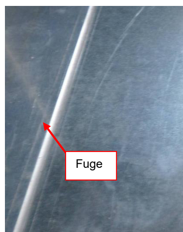
Abbildung 43: Abdichten der Geräteteilung (Fuge) mit Dichtmasse
