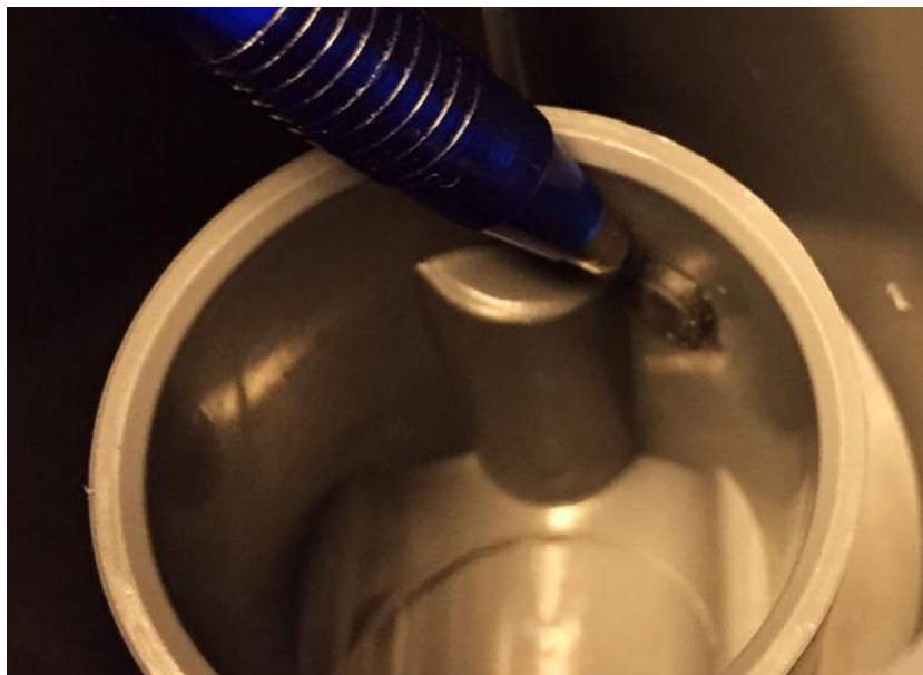
Abbildung 78: Druckseitige Installation: schwarzen Verschlussstopfen entfernen
