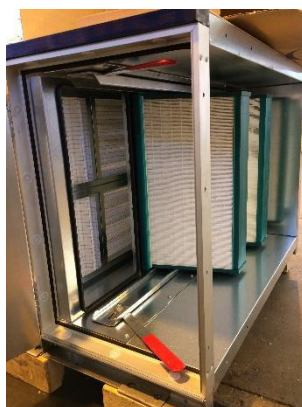
Abbildung 56: Reihenfolge laut Filterrahmenraster beachten
