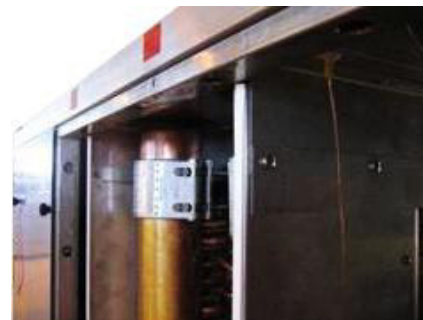
Abbildung 67: Montierte STRAUB Kupplung
