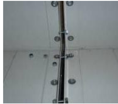
Abbildung 37: Verbindung mittels Einbauwinkel
