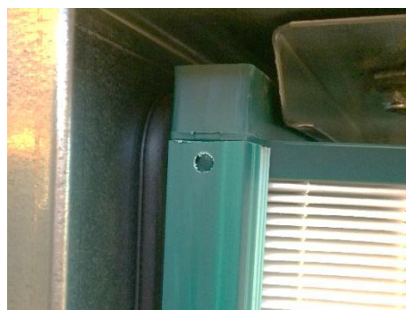
Abbildung 59: Kontrolle, ob Filter auf Dichtung aufliegt
