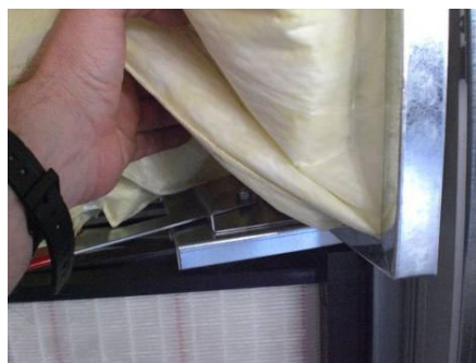
Abbildung 54: Filtertaschen anheben
