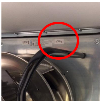
Abbildung 80: Drehrichtungskennzeichnung EC-Ventilator
