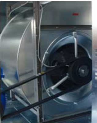
Radial fan with belt drive Radialventilator mit Riemen- trieb Ventilatore radiale con tras- missione a cinghia
