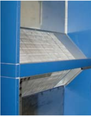
Plate heat exchanger Plattentaucher Recuperatore statico
