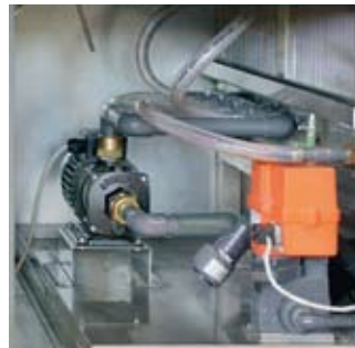
Cebtrifugal pump for adiabatic cooling Axiale Kreiselpumpe für adiabate Kühlung Pompa centrifugale per raffreddamento adiabatico
