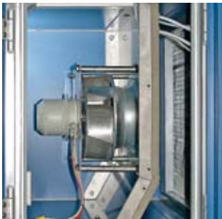
Fan section Zu- und Abluftventilator Ventilatore
