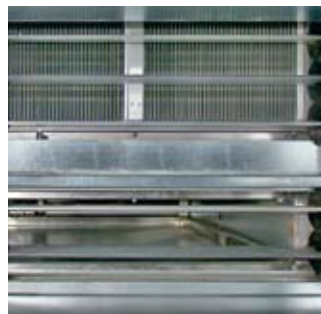
Fresh air damper and by-pass damper Frischlufklappe und Frisch-Bypassklappe Serranda per aria esterna e serranda by-pass
