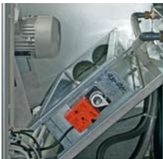
Damper for recirculating air Umluftklappe Serranda aria di ricircolo
