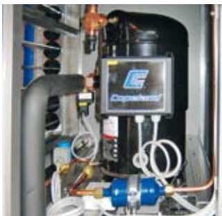
Compressor Kältemittel-Kompressor Compressore
