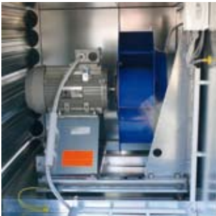
Fan section Zu- und Abluftventilator Ventilatore
