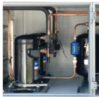
Cooling section with scroll compressor Kälte-Modul mit Kompressoren Sezione di raffreddamento con compressore scroll
